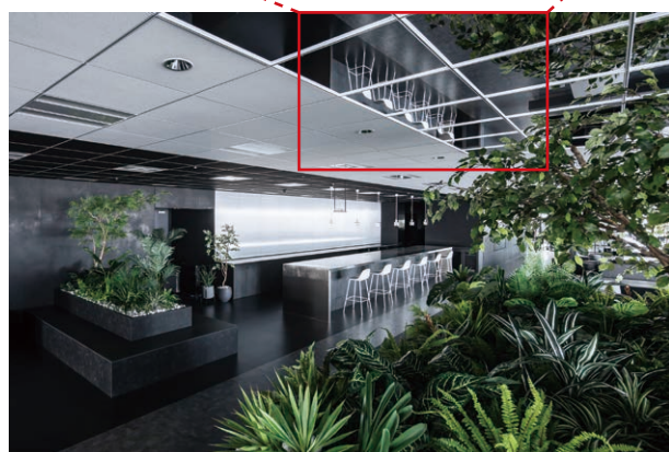
Fujitsu Uvance Kawasaki Tower designed by コクヨ(株) 撮影 (株)エスエス企画
